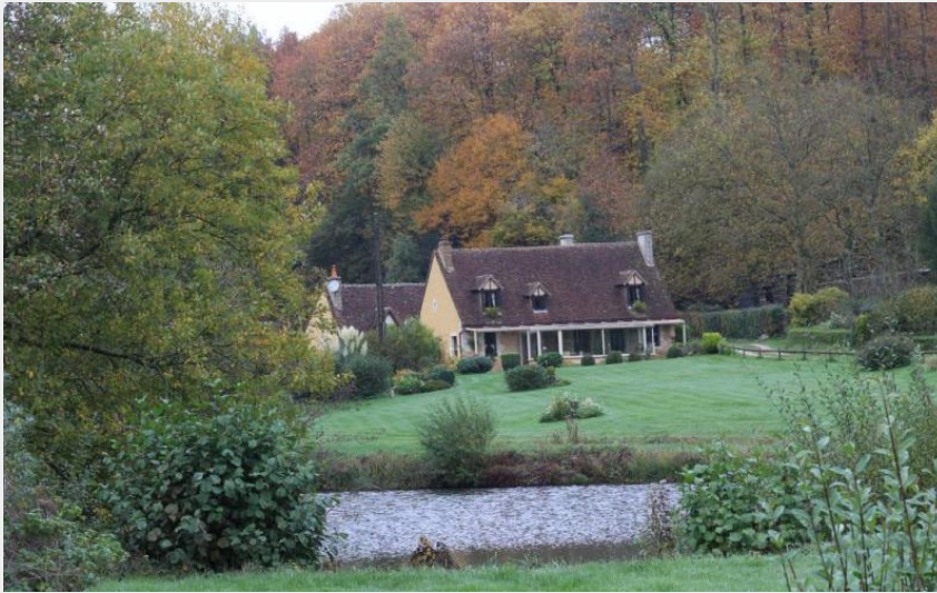
Crédit photo : Le Vauperdu (© Gîtes de France Orne)
